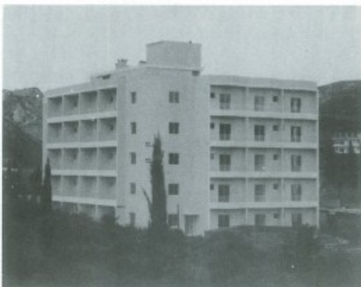
Dos pisos del Asilo "San Vicente de Paulo" fueron puestos en servicio gracias al apoyo del C.M.L.
