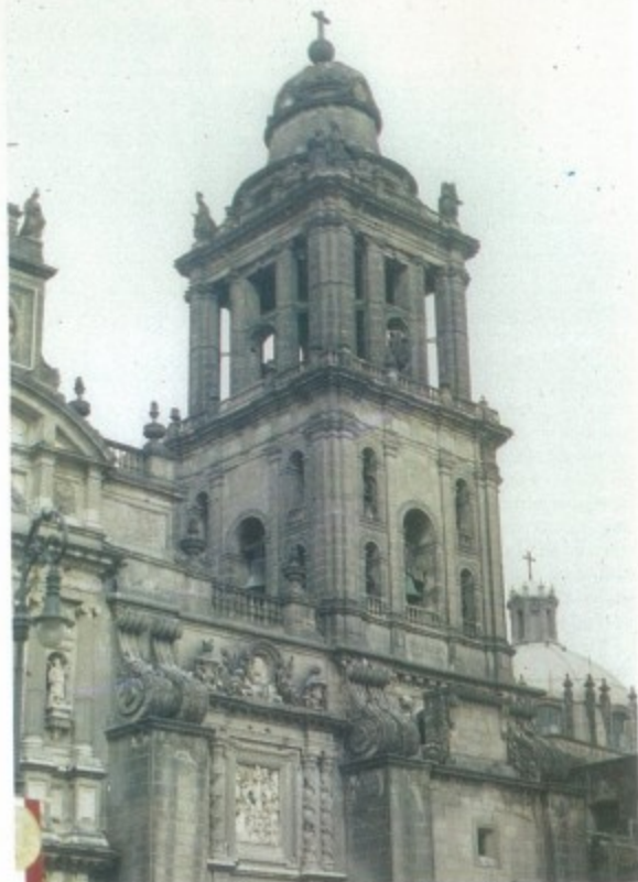
Majestuosa obra patrimonial
