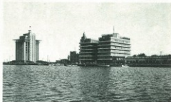
Vista del Banco de México desde los muelles.
