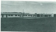
Escuela primaria Salvador Díaz Mirón, construida bajo los auspicios del Club Libanés de Veracruz.
