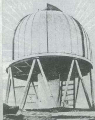
Vista parcial del observatorio.
