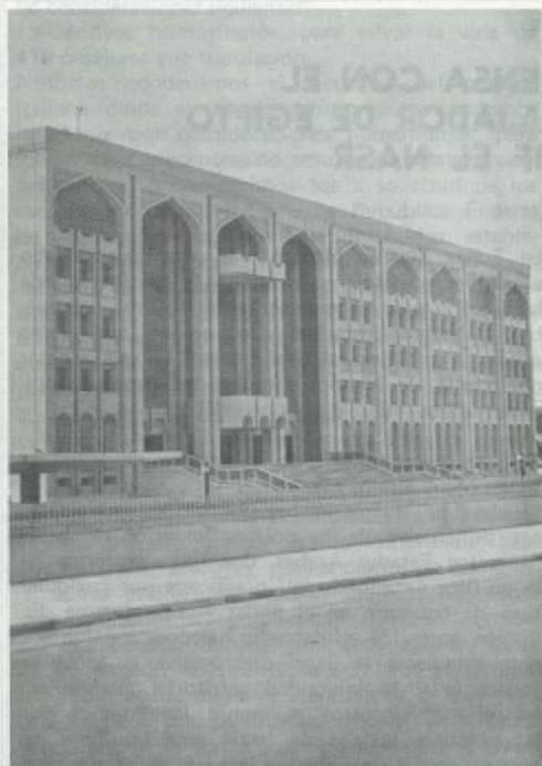
Otra muestra de la arquitectura moderna en Qatar.
