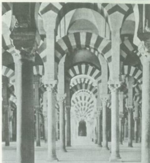
Córdoba.- Mezquita, laberinto de columnas
