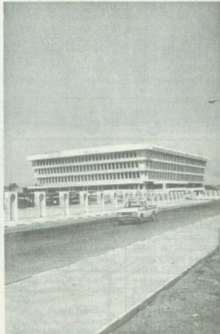
مبنى وزارة الداخلية
