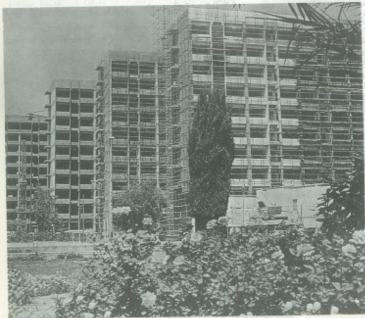
Se aplican métodos modernos dentro de la construcción para la creación de complejos habitacionales.
