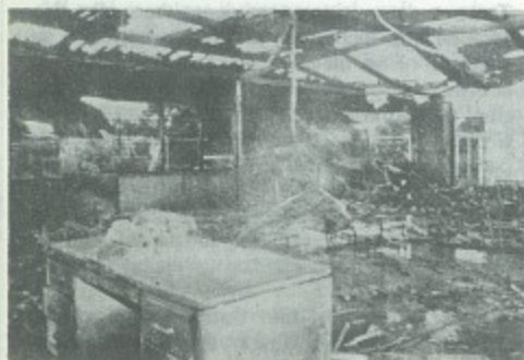
Destrucción y muerte fue el saldo que dejó el sismo en varios estados de la República. Aquí una foto elocuente de una escuela de Huajuapán de León, Oaxaca.
