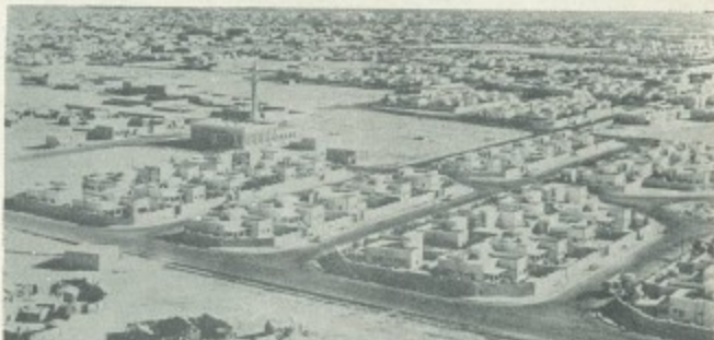
Unidades habitacionales que construye el gobierno de Qatar para las clases populares.
