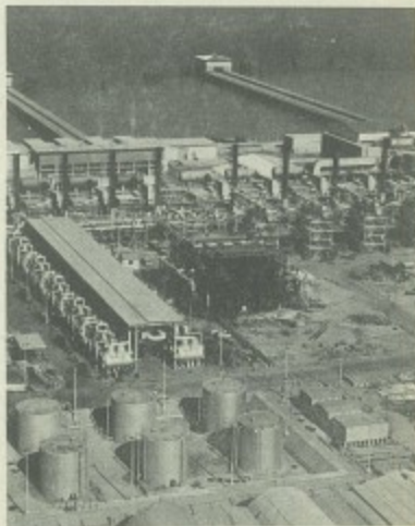
Planta destiladora de agua en Kuwait.
