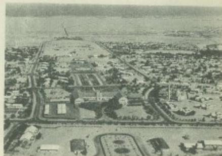
Una visita aérea de la Avenida Central de Al-Ahmedi.
