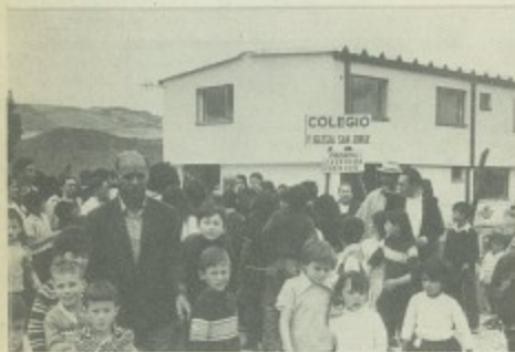
Fachada de la Iglesia y Colegio San Jorge, edificado con el trabajo y entusiasmo de Monseñor Gabriel Estefan,
