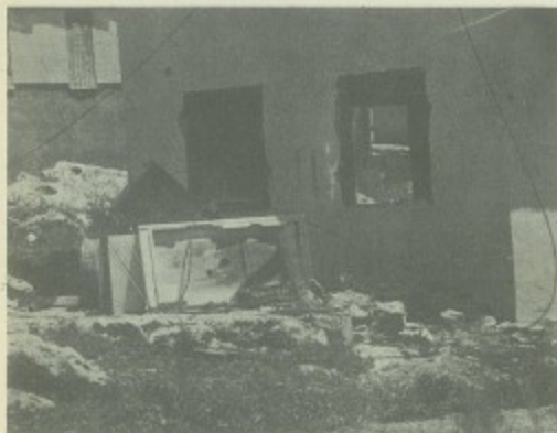
En Jirs El-Basha, después de los combates particularmente violentos, no quedó prácticamente nada de esta construcción.
