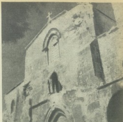
Este es un aspecto del drama en la ciudad de Jerusalén: un templo cristiano, la iglesia de Santa Ana, muestra en su fachada los grandes destrozos causados por bombas israelitas.
