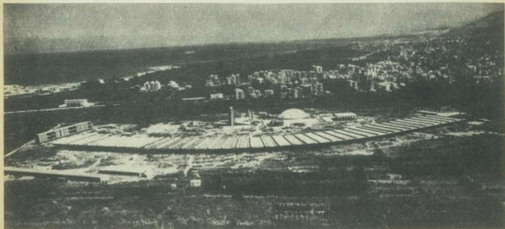
Una vista de las instalaciones de la Feria Internacional de Trípoli. El histórico puerto Libanés será el centro de confluencia del mundo entero en 1971.
