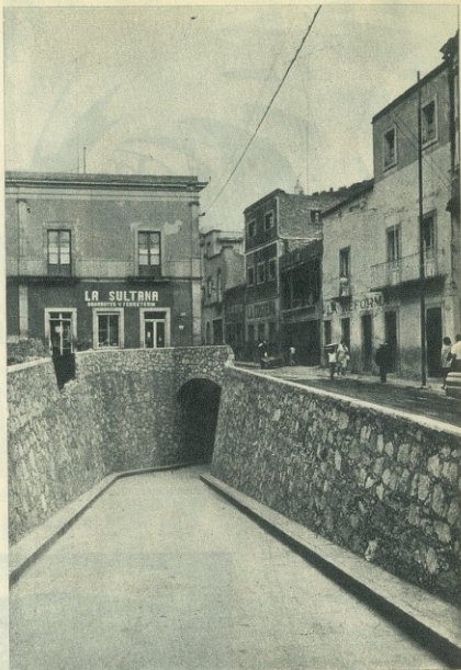
Una de las cinco salidas de la calle subterránea Miguel Hidalgo.
