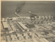
Aspecto general de la Planta de refinación que convierte el agua salina en petróleo, en el Kuwait.
