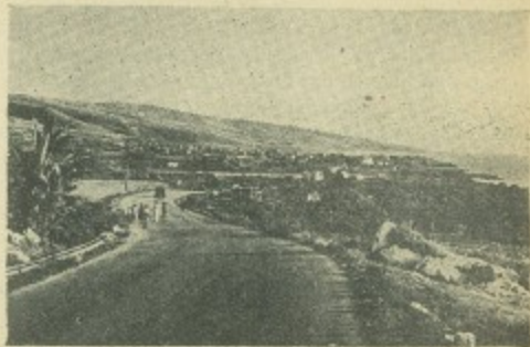
Carretera en las montañas.
