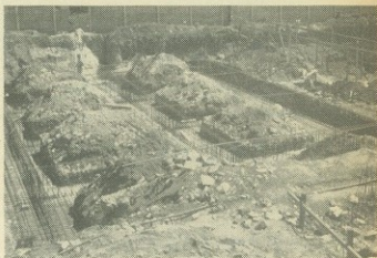
Cimentación del gimnasio y baños del Club Libanés.
