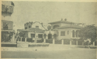
Aspecto general del Edificio de la Legación después de ejecutadas las obras de ampliación.
