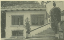
La nueva ala que se construyó, la cual consta de los salones para recepciones en planta alta, y el local para actividades culturales en la planta baja.
